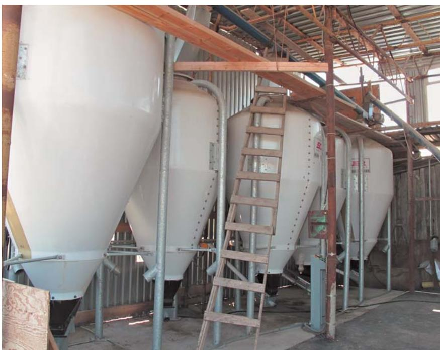
*Рядом с фермой установлено пять силосов в соответствии с пятью основными компонентами рационов*
