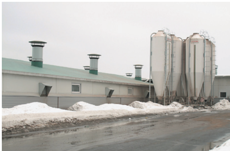
В каждом из 8 зданий фермы 2500 откормочных мест
