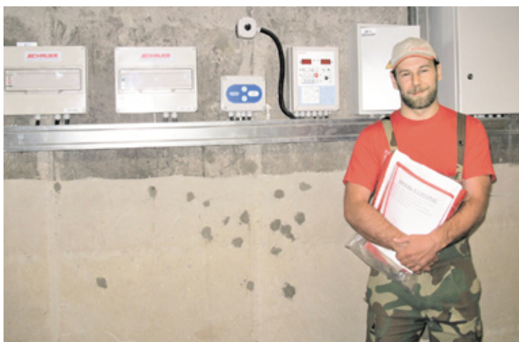
Температура и уровень вентиляции в секциях поддерживаются автоматически и отображаются на электронном табло при входе в цех
