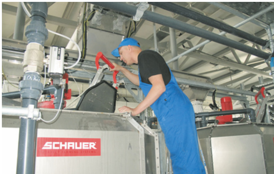
Идет наладка системы жидкого кормления
