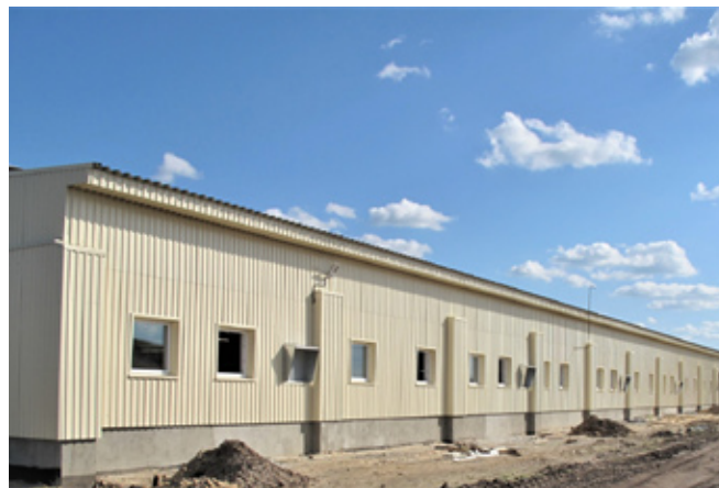
К концу года стройка полностью завершится
