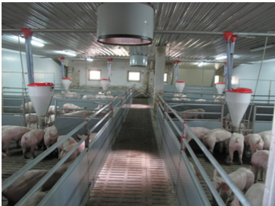
Пористые подшивные потолки способствуют хорошей вентиляции цехов
